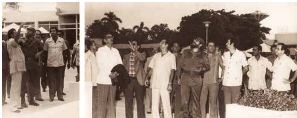
Fig. 10.5. El Comandante recorre las instalaciones recién terminadas del bloque principal del hospital.
