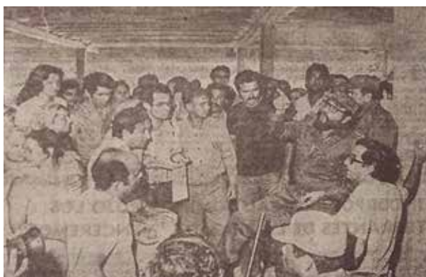
Fig. 10.2. Visita Fidel, en jornada de "Domingo Rojo", las obras de ampliación del hospital. Conversa con el doctor Álvarez Cambras sobre el desarrollo y las características de la construcción y de las instalaciones.
