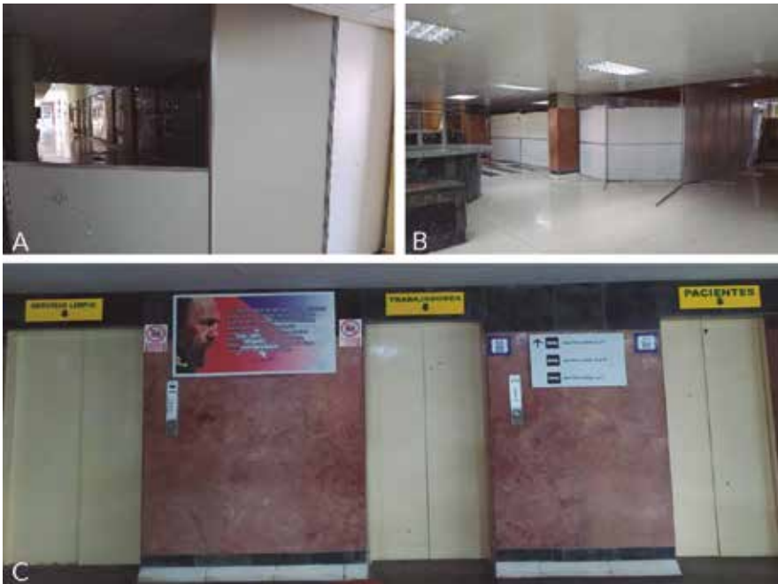
Fig. 17.1. Barreras entre las zonas. A: de lavandería a zona amarilla. B: montaje de barrera entre la zona amarilla y administrativa. C: segregación del acceso por elevadores a la zona amarilla. Por el elevador lateral bajaba el servicio sucio.
